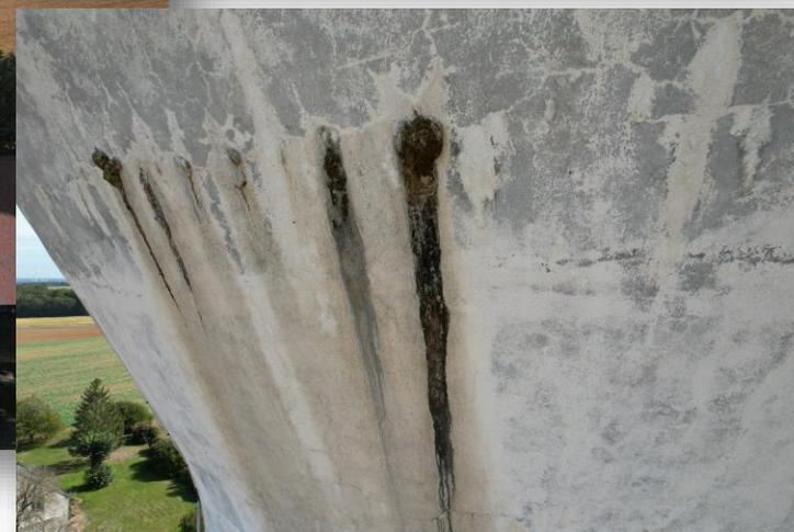
Coût : 73 222<sup>e</sup> HT Mise en œuvre d'un revêtement d'étanchéité en résine époxy
