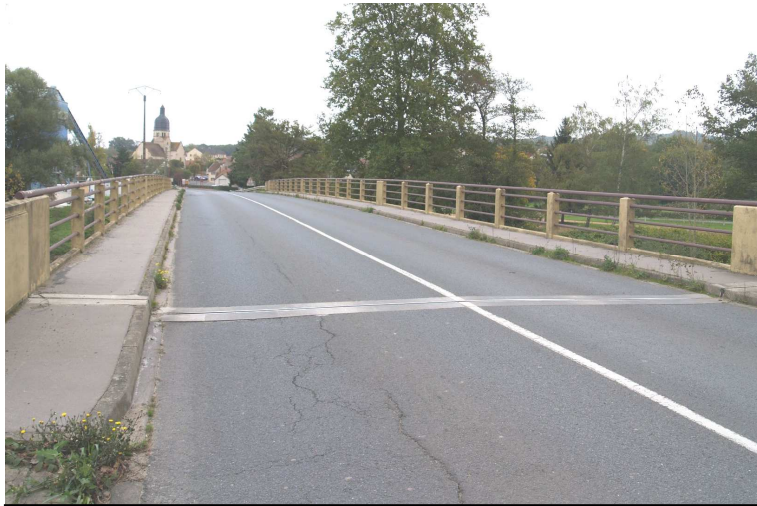
Chaussé et trottoirs depuis RD
