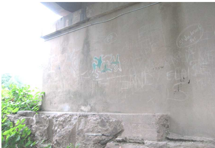
Vue sur l'état du pied de la culée rive droite (C3)
