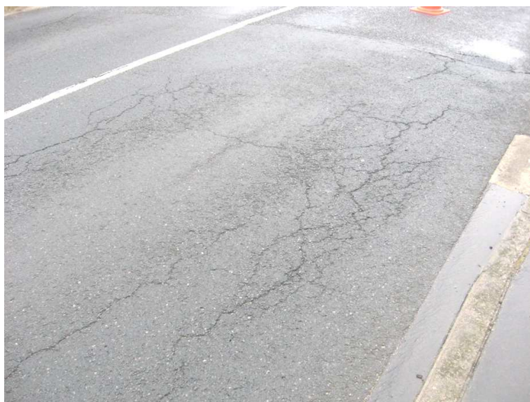
Fissures et léger orniéage - côté amont RD
