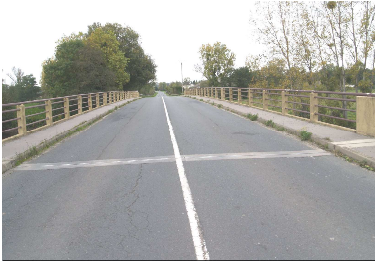
Chaussé et trottoirs depuis RD
