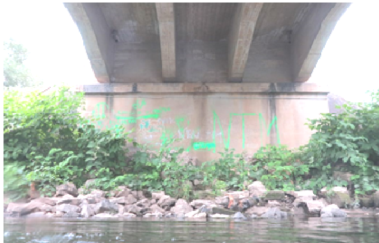
Elévation de la culée rive droite (C3)
