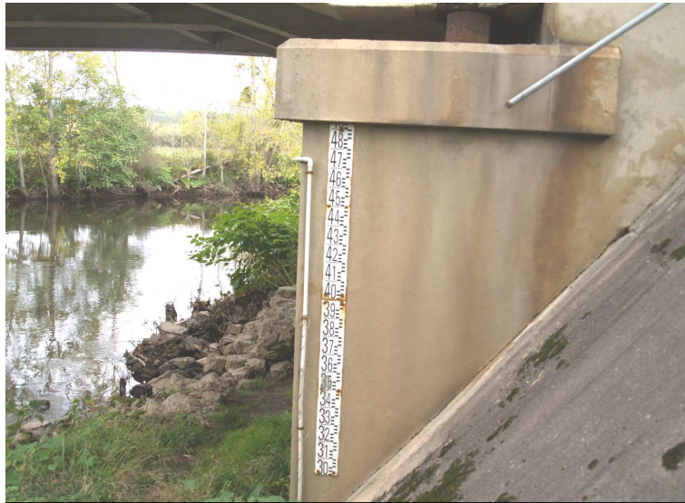
Echelle limnimétrique rive droite - coté amont
