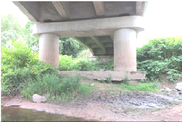
Élévation de la pile P1 rive gauche
