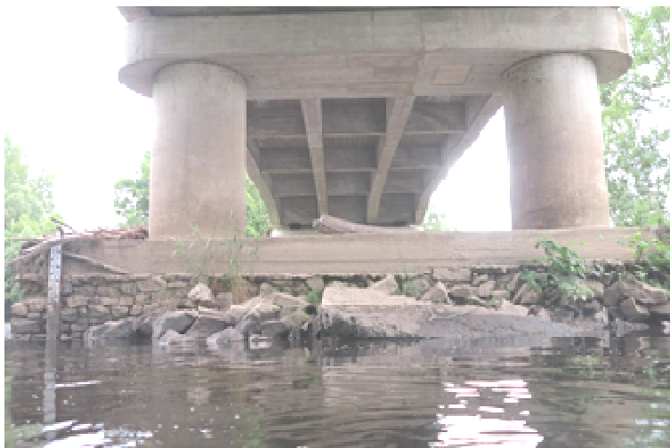
Vue générale sur la pile P2
