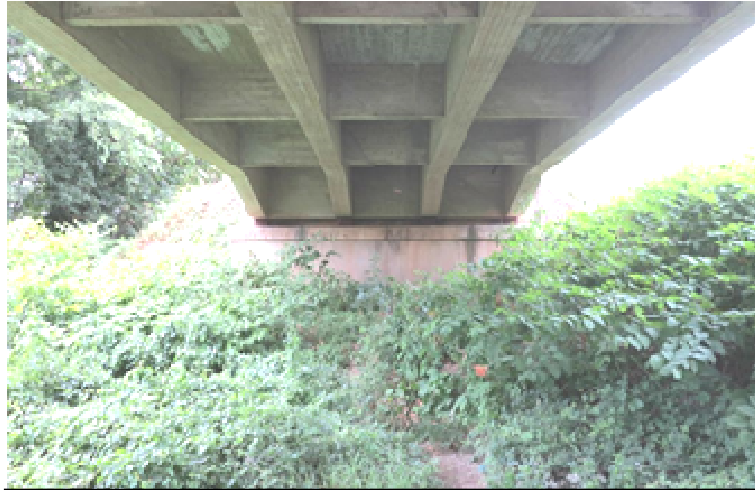
Elévation de la culée rive gauche (C0)
