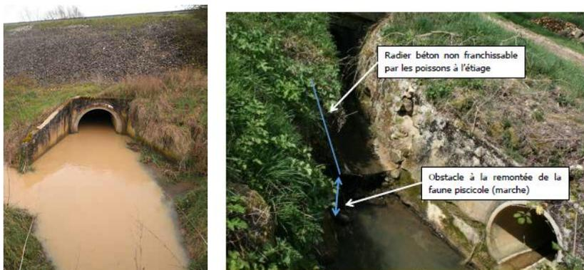
Figure 5 : Passages busés sous l'autoroute A20 et chemin agricole (éléments extraits du dossier)
